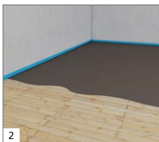
2 Auftragen des wedi 320 Fliesenklebers auf den Holzuntergrund.
