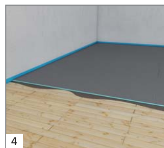
4 Bauplatte fugenversetzt in Kleber einbetten.
